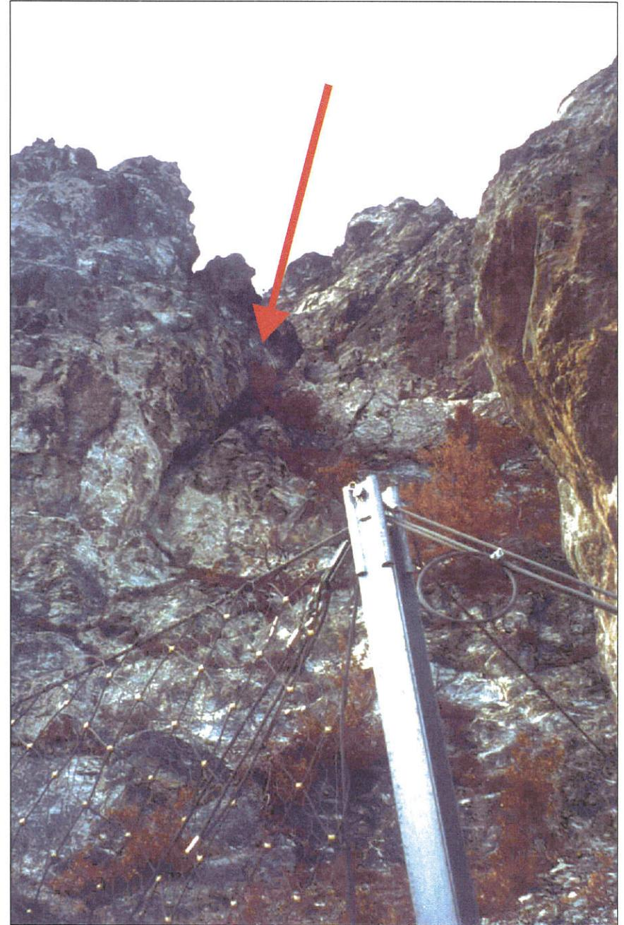
Instabilità 1.1. Lato W (a sinistra) e lato E (a destra). Si notano il pilastro principale nella parte anteriore ed il cuneo roccioso posteriore
